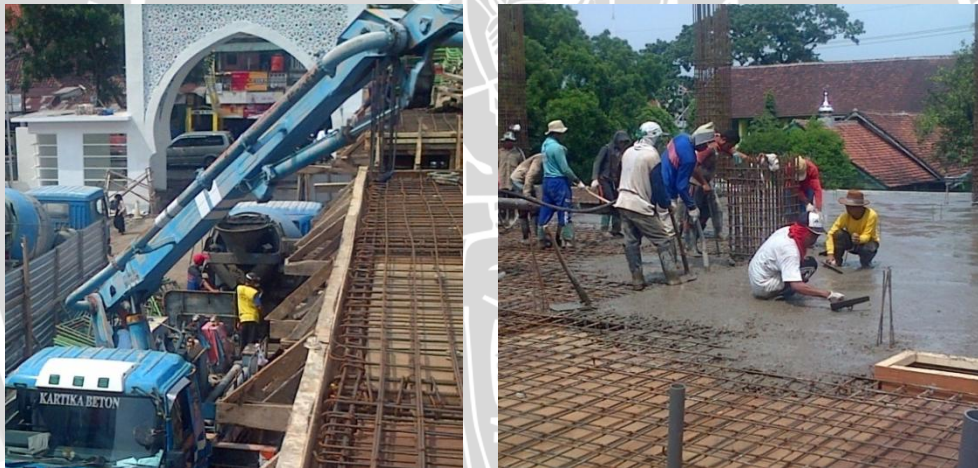
Gambar 2.2 Beton ready mix Sumber : Dokumentasi proyek UNISMA 2016
