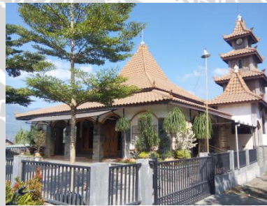
Gambar 4.35 Bangunan Masjid Pada Kawasan Studi
