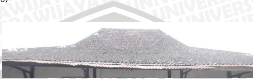
Keseluruhan bangunan menggunakan atap limasan dengan ketinggian sekitar 1,5m. material atap menggunakan genteng tanah liat.
