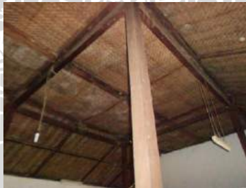
Gambar 4.40. Bentuk dan jenis atap kasus rumah 6 (a). Tampak depan (b). Tampak belakang (c) (d). Tampak samping.
