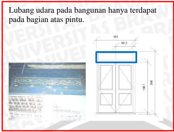
Gambar 4.76. Ventilasi kasus rumah 12.
