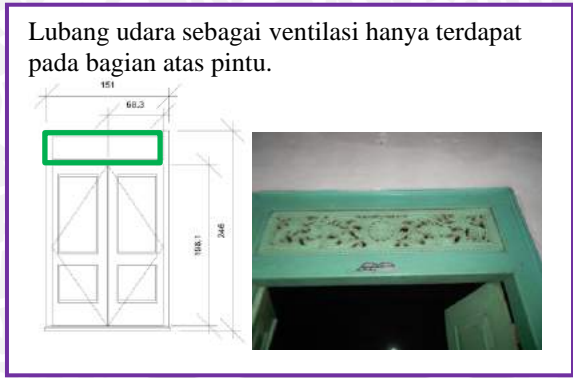
Gambar 4.64. Ventilasi kasus rumah 10.
