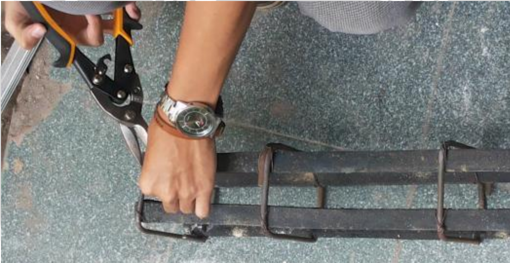
Gambar 4. Pemasangan sengkang
