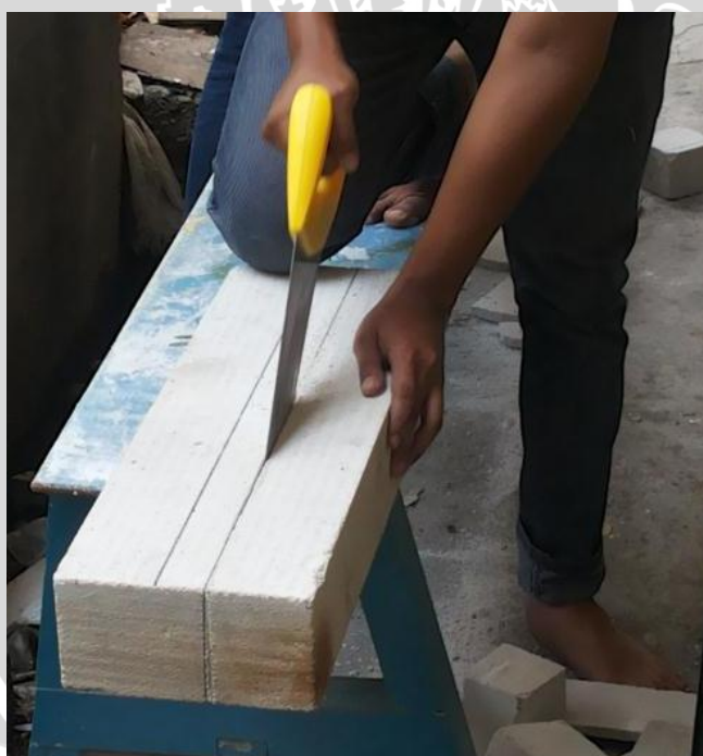
Gambar 2. Pematongan bata ringan
