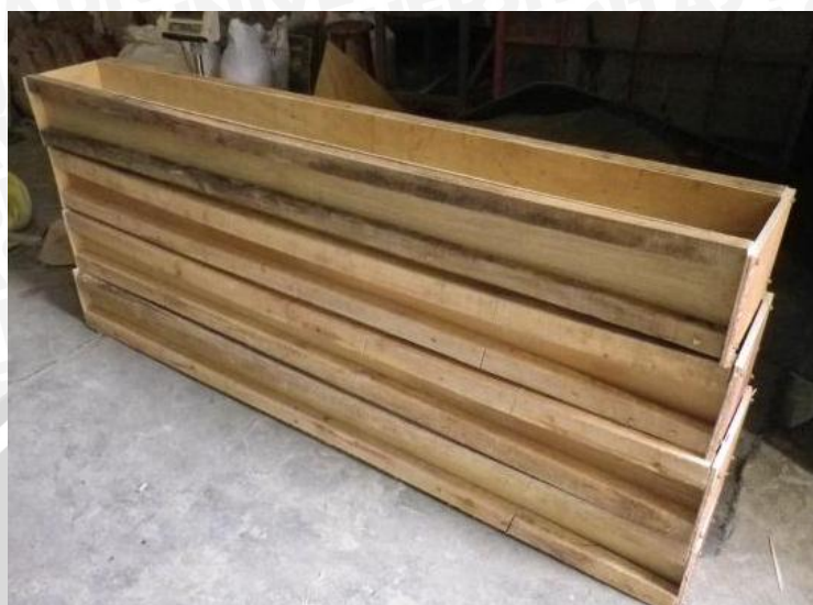
Gambar 1. Bekisting balok
