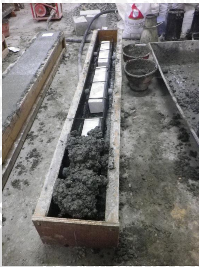
Gambar 5. Pengecoran balok
