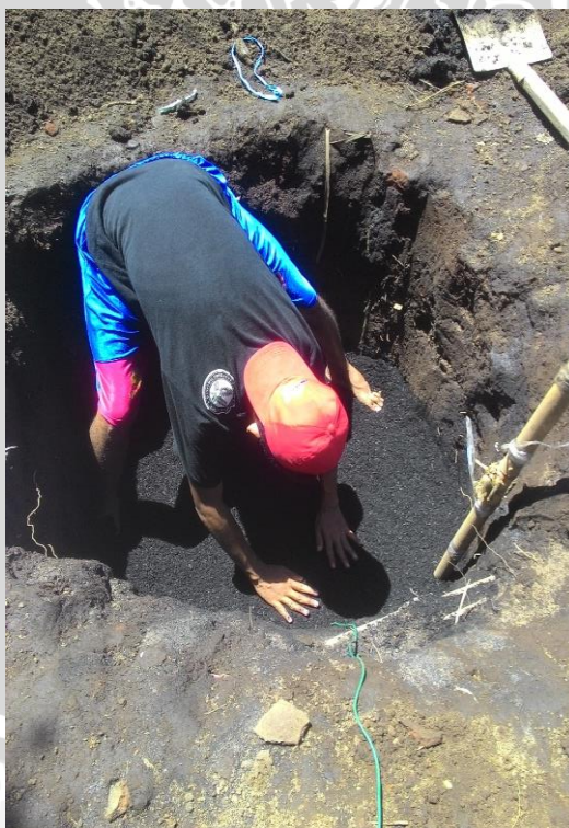
Gambar 10. Penutupan lubang sebelum pengukuran
