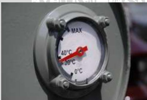
**Gambar 2. 10 Indikator Level Minyak Transformator**
