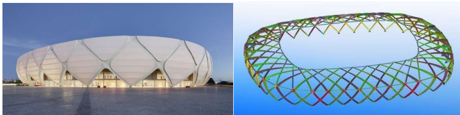
Gambar 2.21 Fasade keranjang buah Amazon dengan rangka diagrid
