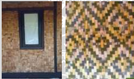
Gambar 2.20 Sasag pada dinding bangunan. (Sumber : Inventarisasi arsitektur dan permukiman tradisional)
