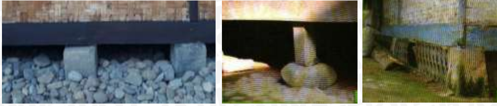
Gambar 2.19 Jenis Pondasi pada bangunan Kampung Adat Sunda. (Sumber : Inventarisasi arsitektur dan permukiman tradisional)
