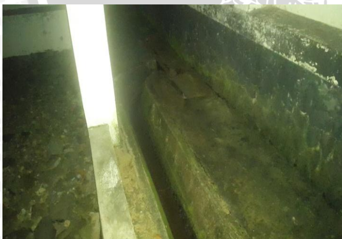
Gambar 4.2 Saluran menuju IPAL Sumber : Dukomentasi Lapangan
