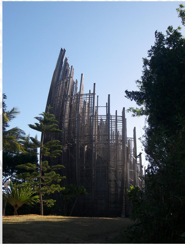
Gambar 2.54 : Material baja di bagian luar bangunan
