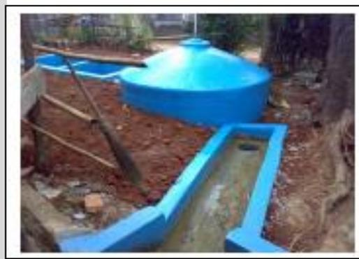
Gambar 2. 4 Desain Biogas Tipe Fiberglass
