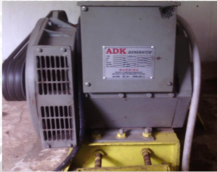
Gambar 4.3 Generator Sinkron 3 Fasa Pada PLTMH Andungbiru 2
