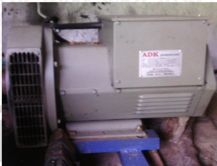
Gambar 4.2 Generator Sinkron 3 Fasa Pada PLTMH Andungbiru 1 Sumber : PT Haneda Sukses Mandiri
