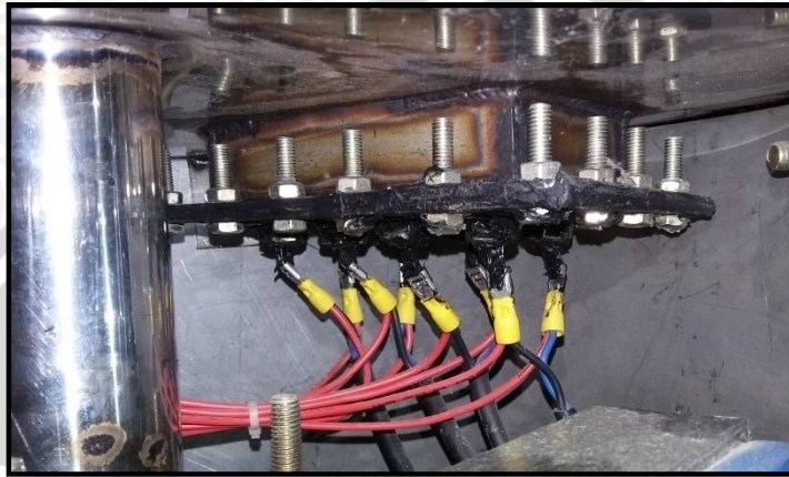
Gambar 4.3 Pemasangan Elemen Pemanas
