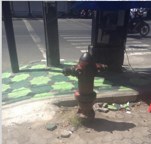
Gambar 4.18 Fire hydran yang berada di sisi timur tapak
