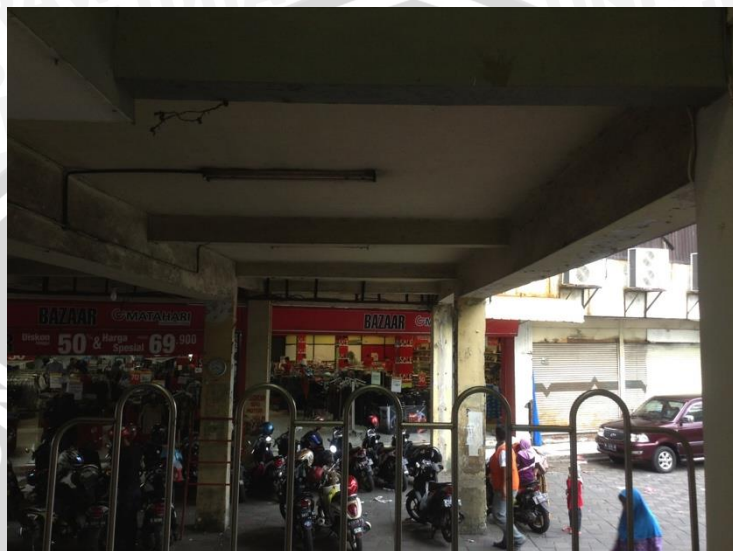
Gambar 4.16 Struktur bangunan eksisting
