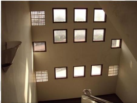
**Gambar 4.44** ventilasi alami pada tiap tangga
