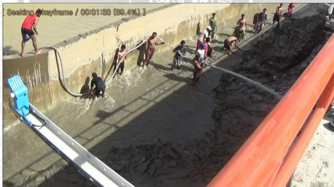
Gambar 5. Kegiatan Pembersihan Endapan Sedimen Sumber : Lembaga UUK BPP FT-UB
