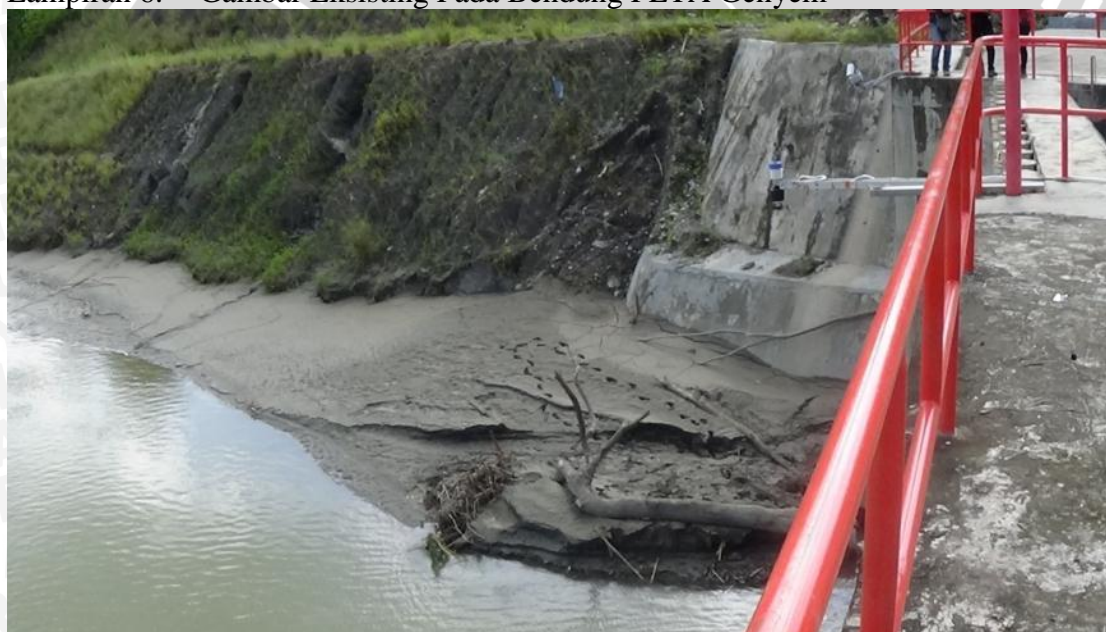
Gambar 1. Endapan Sedimen Di Depan Intake Kantong Lumpur Sumber : Lembaga UUK BPP FT-UB
