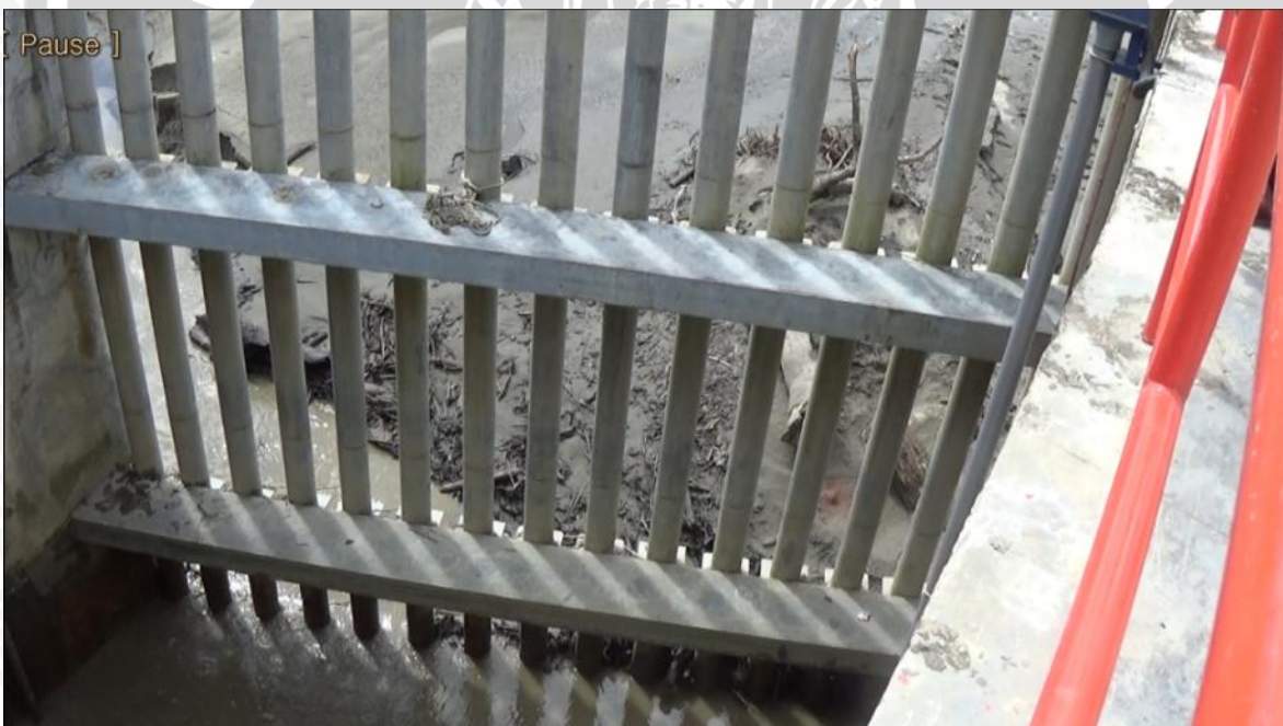
Gambar 3. Sedimen di Depan Trashlog Sumber : Lembaga UUK BPP FT-UB
