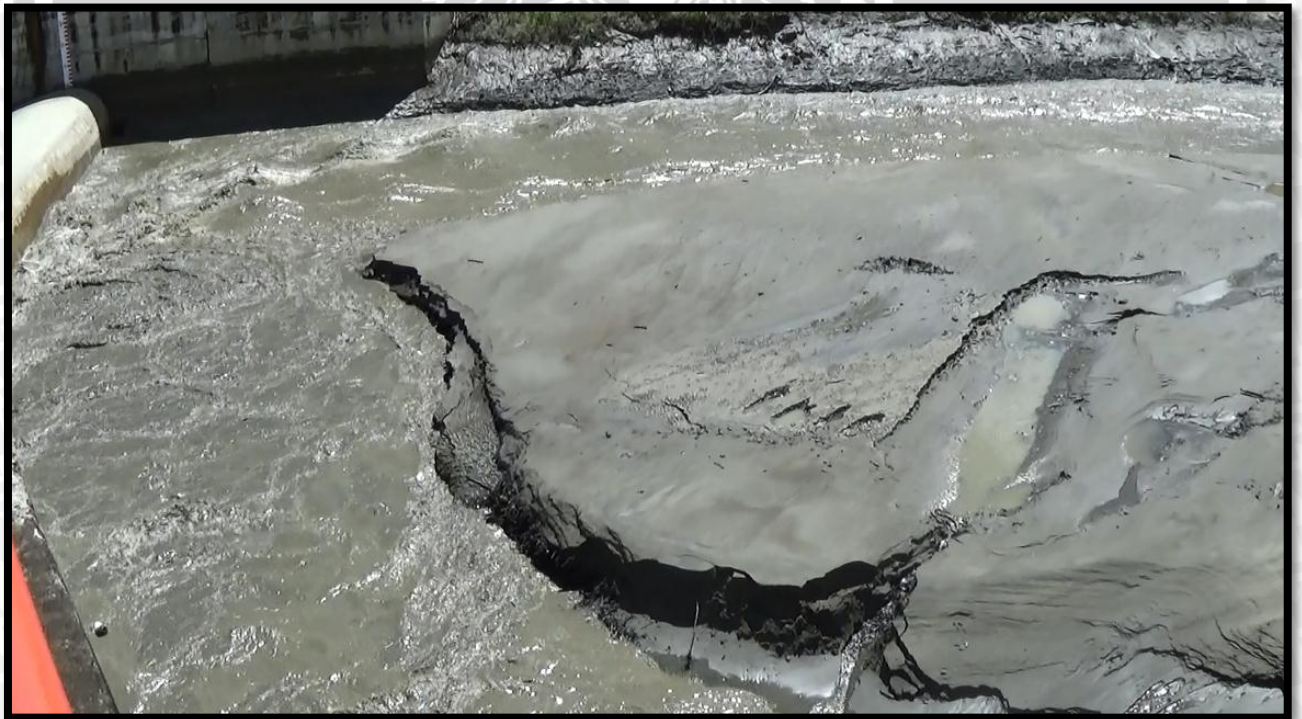
Gambar 3.9. Sedimen Bagian Hulu Bendung PLTA Genyem Sumber: Lembaga UUK BPP FT-UB
