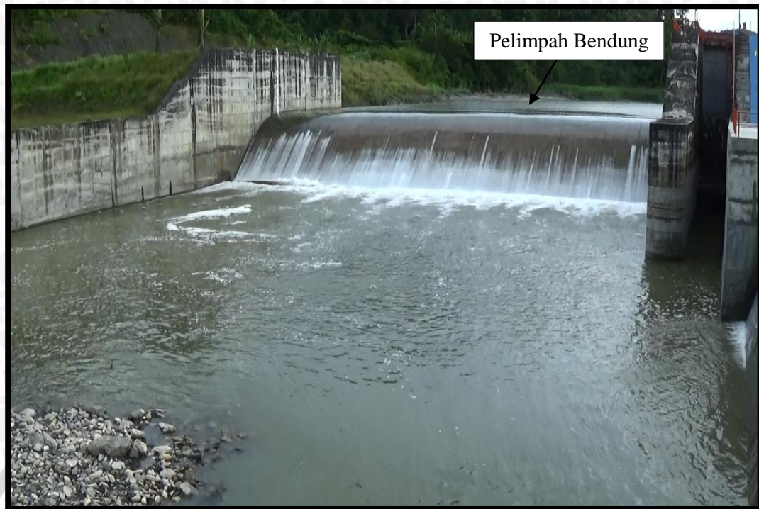
Gambar 3.4. Pelimpah Bendung PLTA Genyem Sumber: Lembaga UUK BPP FT-UB
