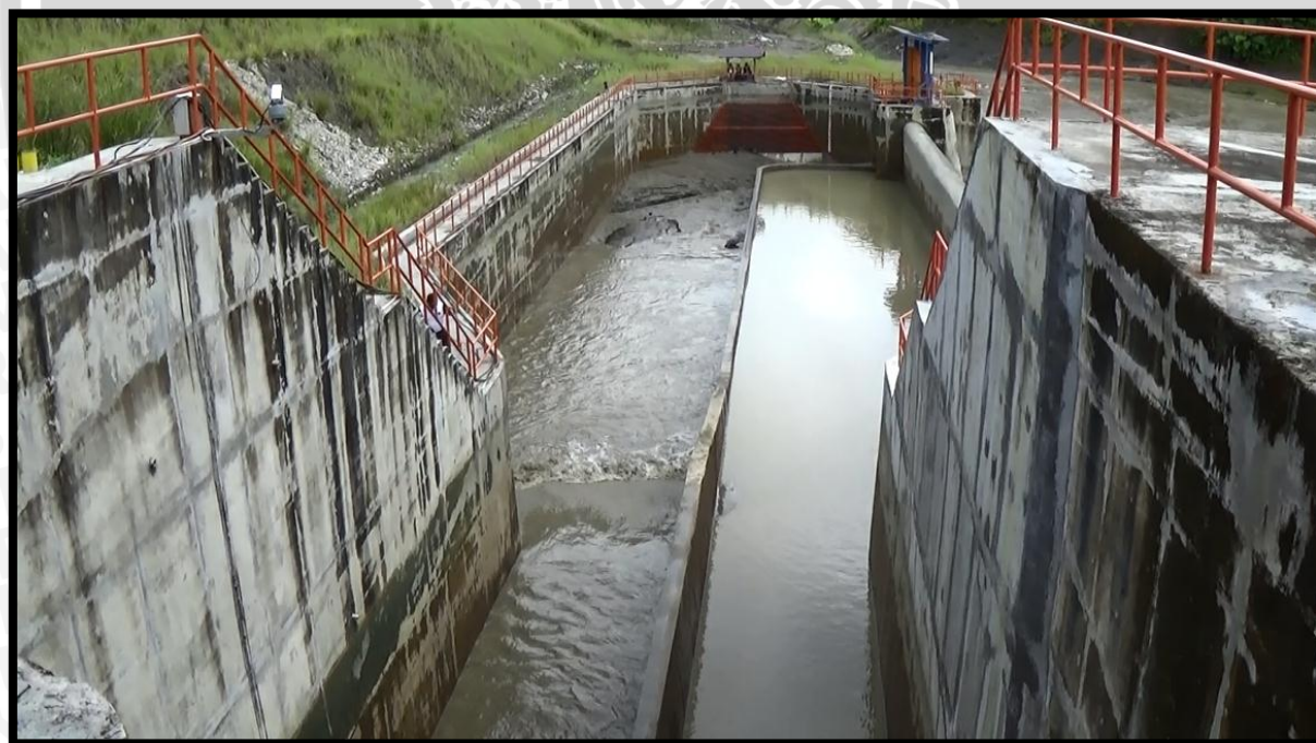
Gambar 3.7. Kondisi Kantong Lumpur Pada Saat Flushing Sumber: Lembaga UUK BPP FT-UB
