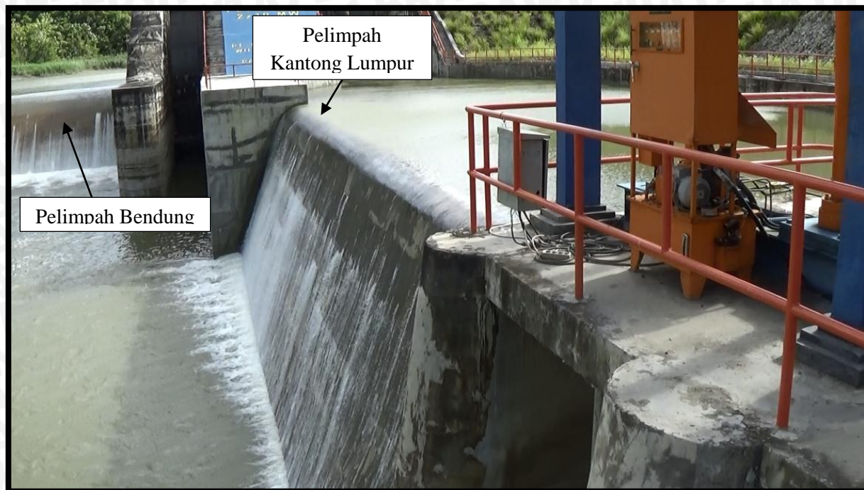
Gambar 3.6. Pelimpah Kantong Lumpur PLTA Genyem Sumber: Lembaga UUK BPP FT-UB
