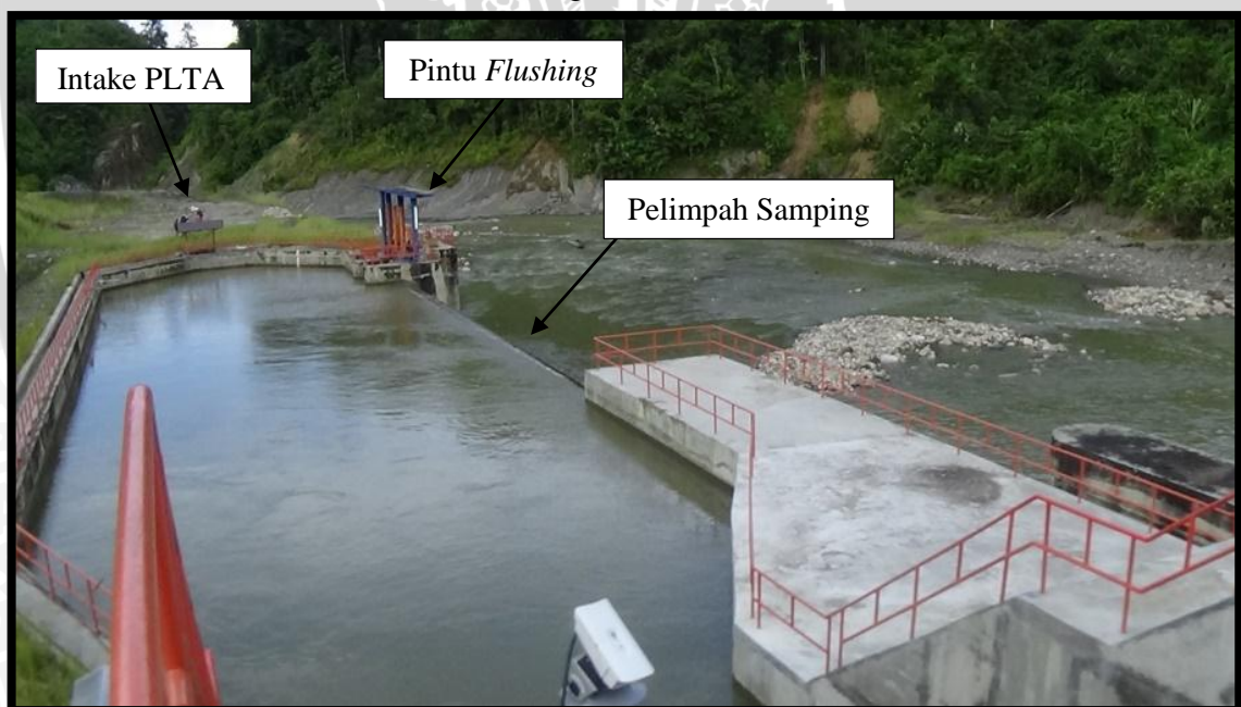
Gambar 3.5. Kantong Lumpur ke Arah Intake PLTA Genyem Sumber: Lembaga UUK BPP FT-UB
