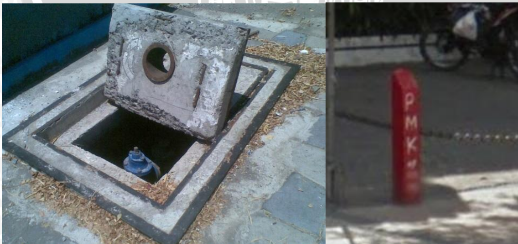
Gambar 4. 6 Sumur kebakaran Sumber : Dinas Pemadam Kebakaran, 2015
