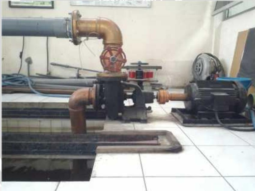
Gambar 3.1 Pompa Sentrifugal
