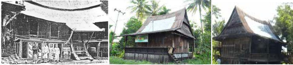
Gambar 2.11. Salah satu jenis Rumah Gadang daerah Pesisir. (Kiri) penampakan Rumah Gadang daerah Pesisir jaman dahulu masih menggunakan atap ijuk dan (kanan) penampakan jaman sekarang menggunakan atap seng (Purwanita Dkk, 2012)
