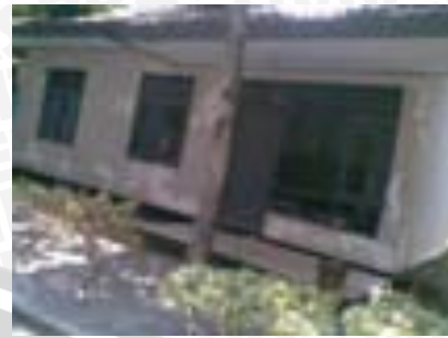
Gambar 1.4 Ruangan yang tidak berfungsi Sumber : Dokumentasi pribadi
