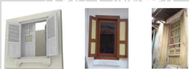
Gambar 2. 11 Jendela rangkap pada bangunan kolonial.
