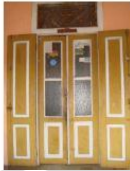
Gambar 2. 10 Pintu rangkap sebagai pintu utama pada bangunan kolonial.
