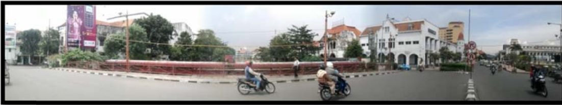
Gambar 4.30 Kondisi Jembatan Merah pada Pagi Hari
