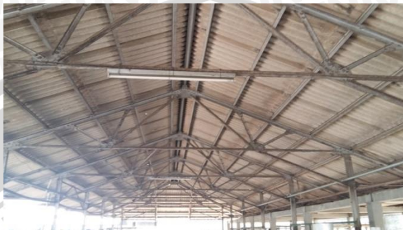
Gambar 2.57 Atap kandang penampungan
