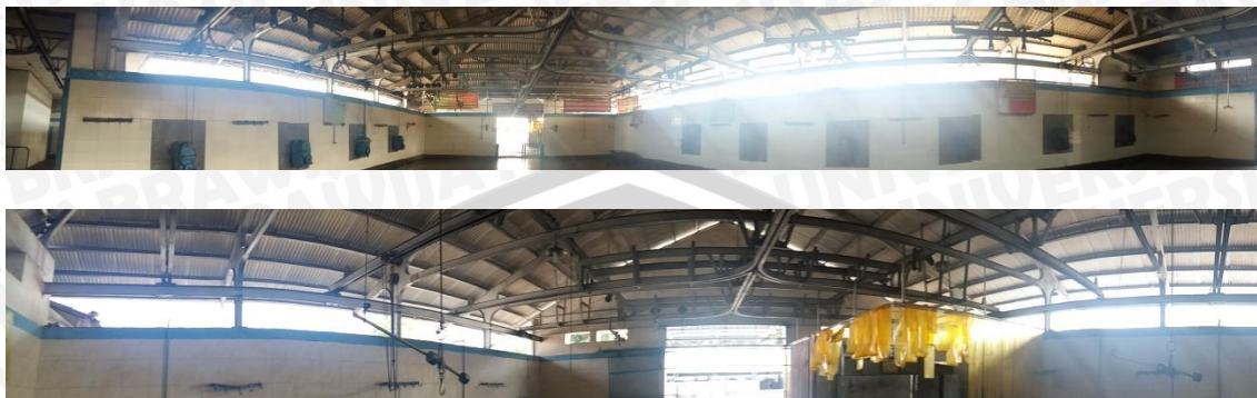
Gambar 2.67 Penghawaan dalam bangunan RPH Kota Malang
