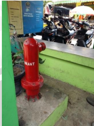
Gambar 2.53 Alat pemadam kebakaran di Pasar Madyopuro
