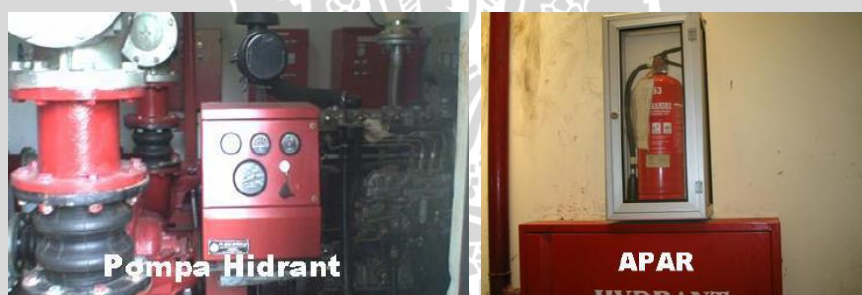
Gambar 2.33 Alat pemadam kebakaran pada Pasar BSD City
