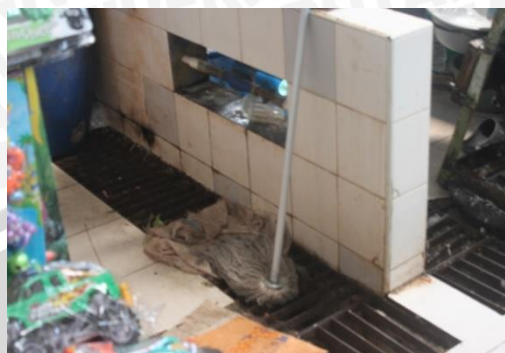
Gambar 2. 32 Drainase pada Pasar BSD City
