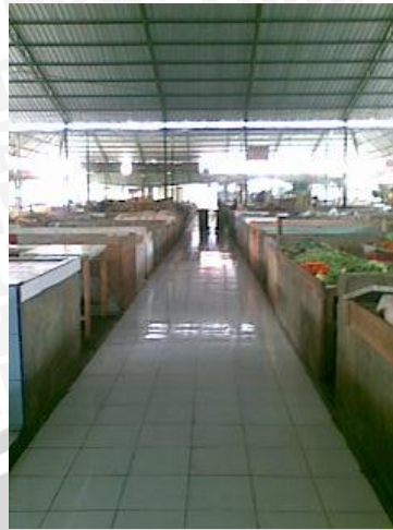
Gambar 2.49 Lantai pada Pasar Madyopuro
