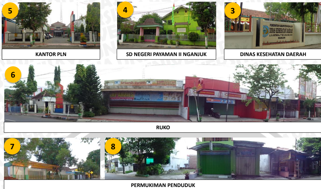
Gambar 4.3 Bangunan di sekitar Gedung Juang 45
