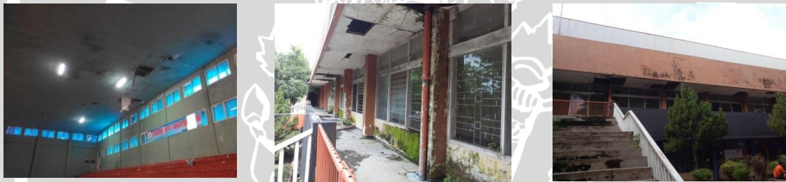
Gambar 2.41 Kondisi Eksisting Gedung
