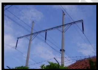
a. Isolator Transmisi
