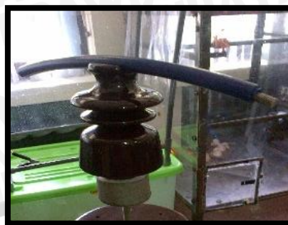
Gambar 3.3 Pemasangan PIN-PEX Sumber : dokumentasi pribadi
