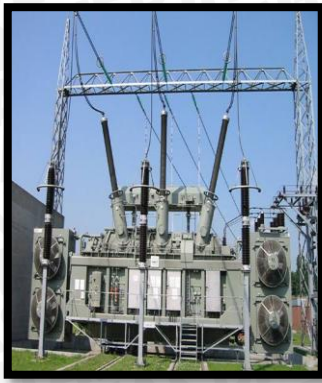
a. Bushing Trafo
