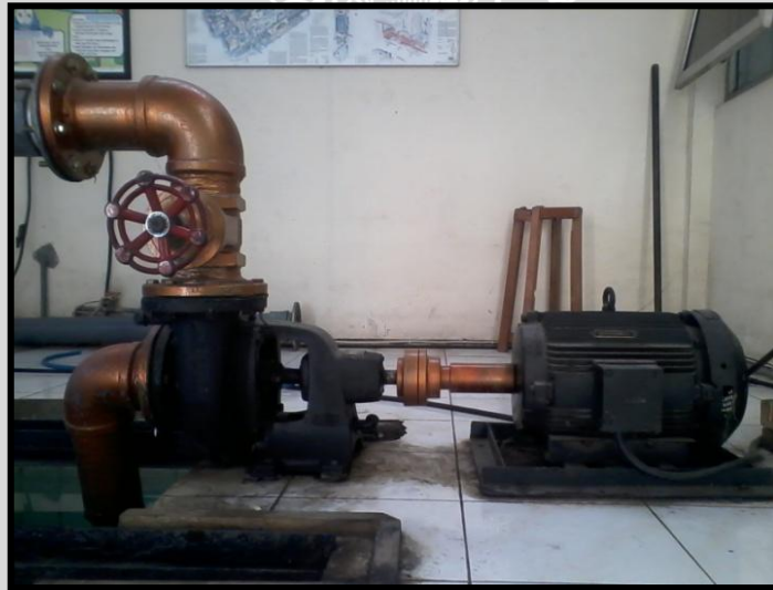
Gambar 3.1 Pompa Sentrifugal
