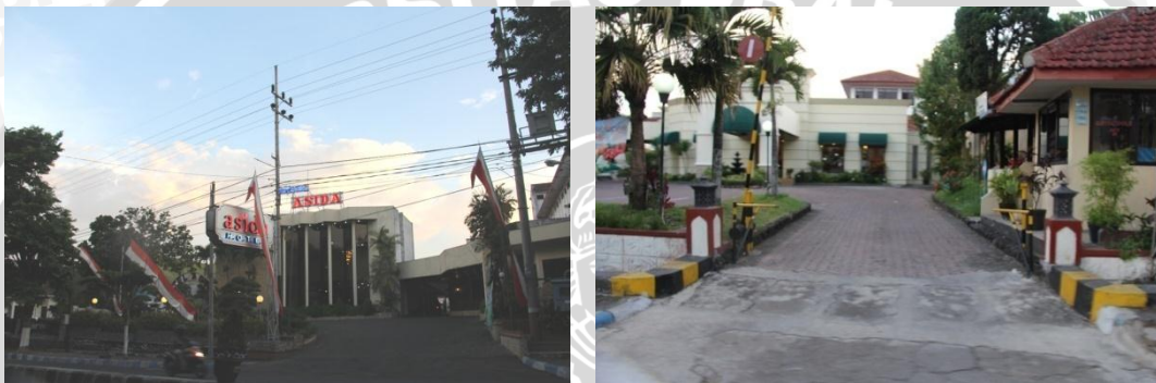
Gambar 4.23 Fasilitas Hotel di Sekitar Tapak
