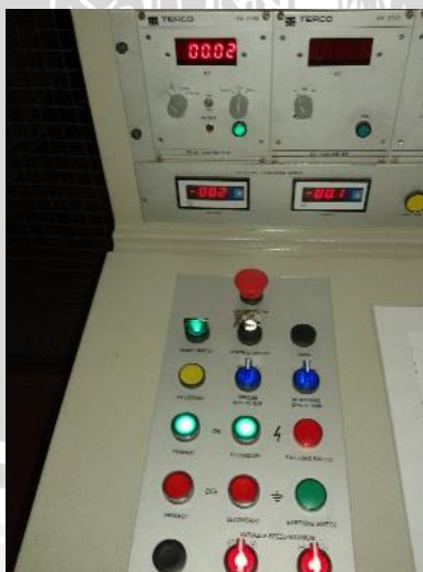
Gambar 8. Alat ukur tegangan tinggi AC dan DC pada control desk
