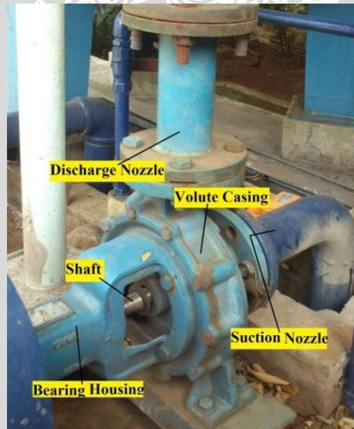
Gambar 2.18 Pompa Sentrifugal dan Komponennya
