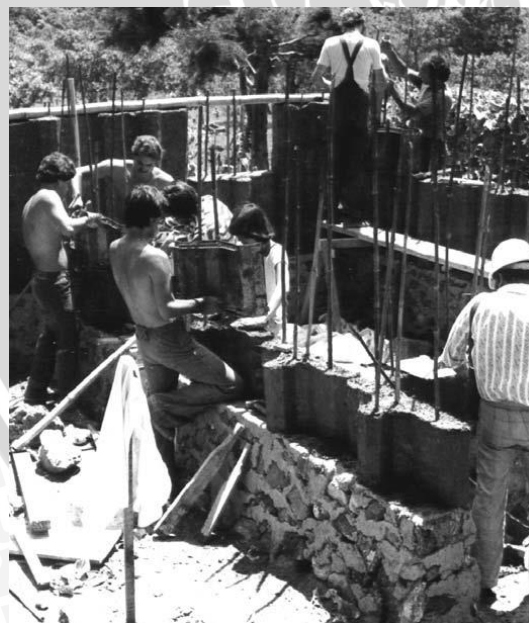
Gambar 2.35 Contoh Gambar Pemanfaatan Tanah Liat Dipadukan Dengan Bambu Di Colombia
