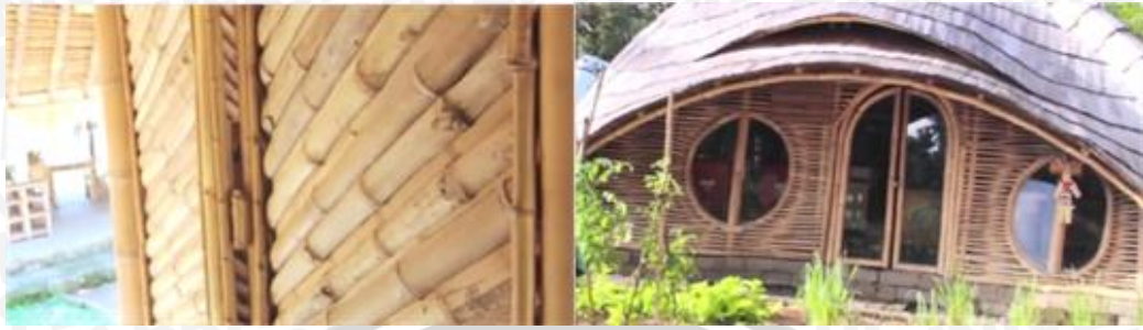
Gambar 2.43 Konstruksi Dinding Pada Bangunan Green School
