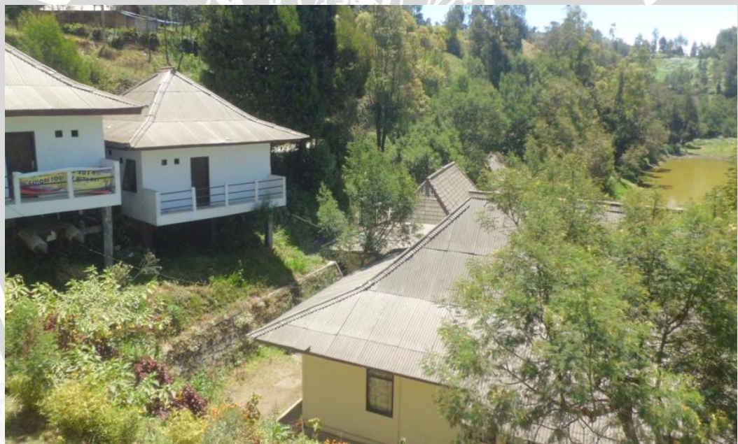
Gambar 2.12 Kondisi Bangunan Dekat Danau
