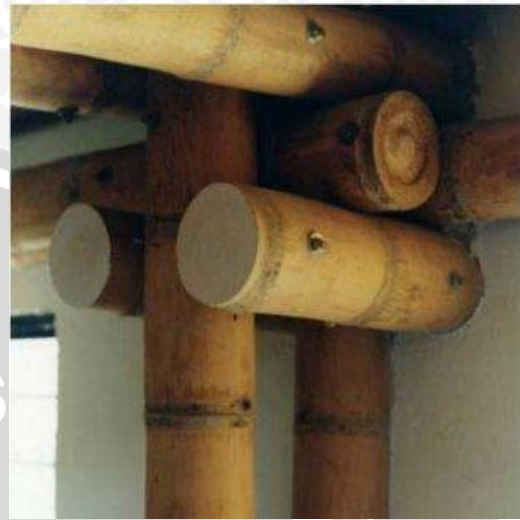
Gambar 2.31 Contoh Gambar Aplikasi Sambungan Menggunakan Baut
