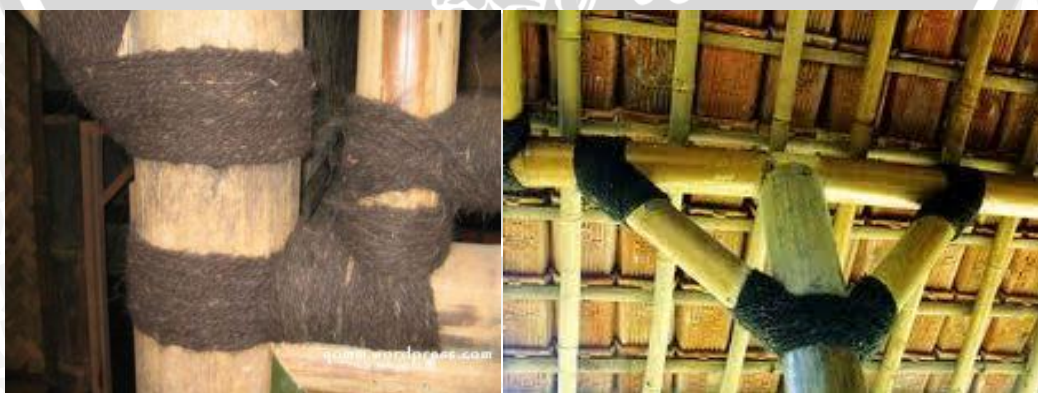
Gambar 2.26 Penyambungan Bambu Dengan Ijuk
