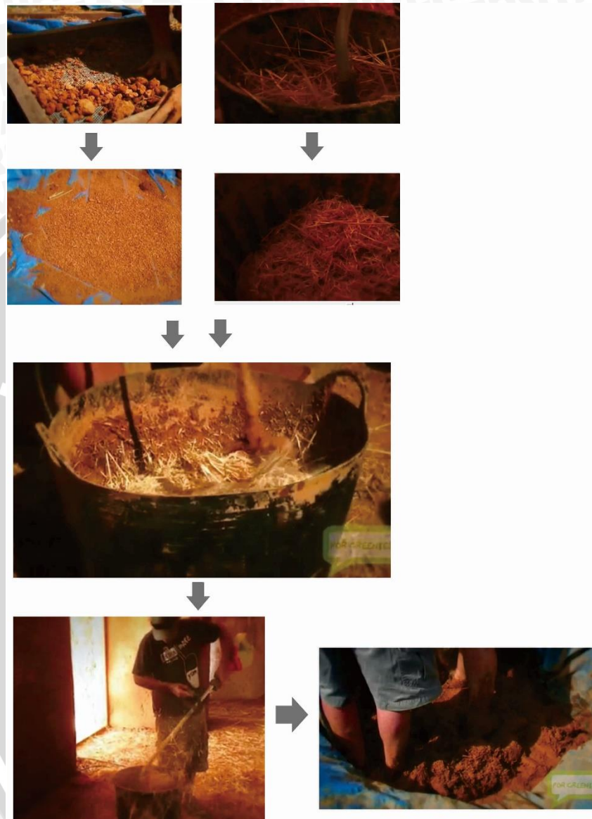
Gambar 2.38 Contoh Gambar Pembuatan Adonan Clay
