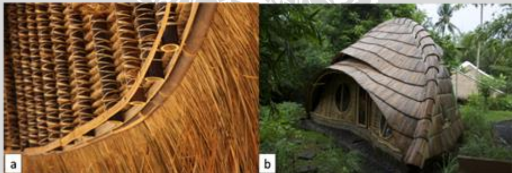
Gambar 2.43 (A) Konstruksi Atap Rumbia, (B) Konstruksi Atap Bambu
