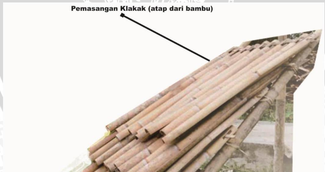
Gambar 4.72 Pemasangan Atap Bilah Bambu
