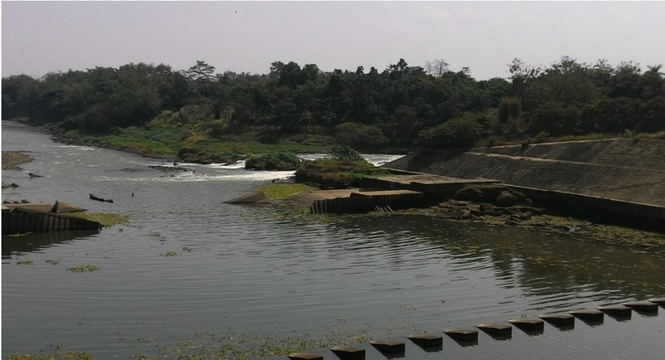
Gambar. Saluran Pembuang ( Tailrace ) PLTA Lodoyo I
