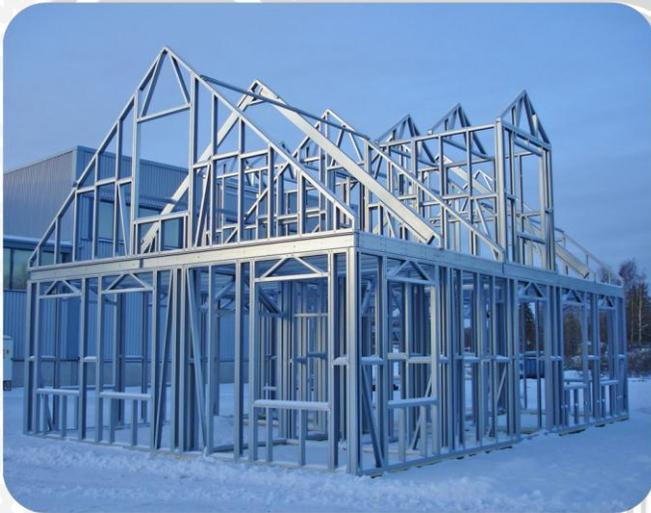
Gambar 4.14 : Contoh konstruksi baja pada bangunan.
