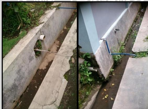
**Gambar 4.36 Kondisi Saluran Drainase: a) Tidak Berfungsi (kering); b) Berfungsi**
