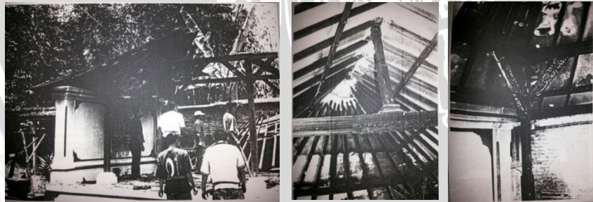
Gambar 4.1 Bale pesandekan yang terbakar Sumber dokumentasi pengurus Pura
