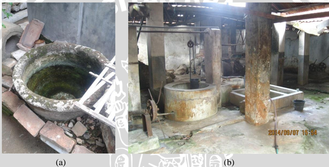
Gambar 4.1 Tempat pencucian kain (a) bak tanah liat (b) bak permanen pada rumah K14.
