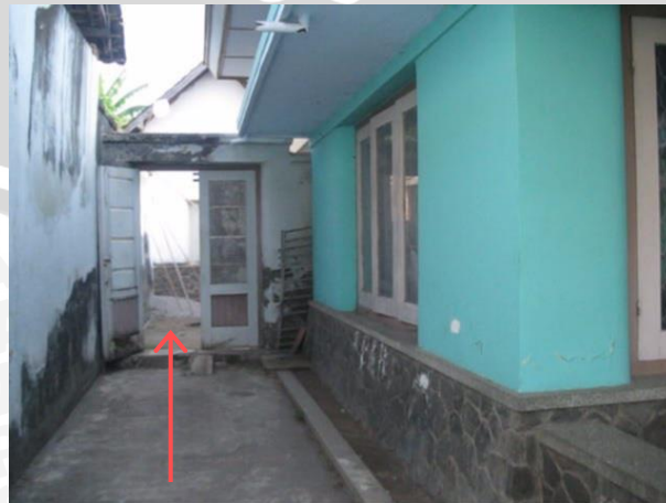
Gambar 4.59 Pintu samping rumah K11 menuju halaman belakang.
