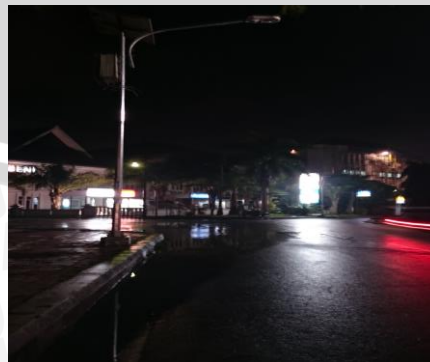
Gambar 2.2 Kondisi lampu penerangan jalan umum dengan sumber energi surya ketika musim hujan
