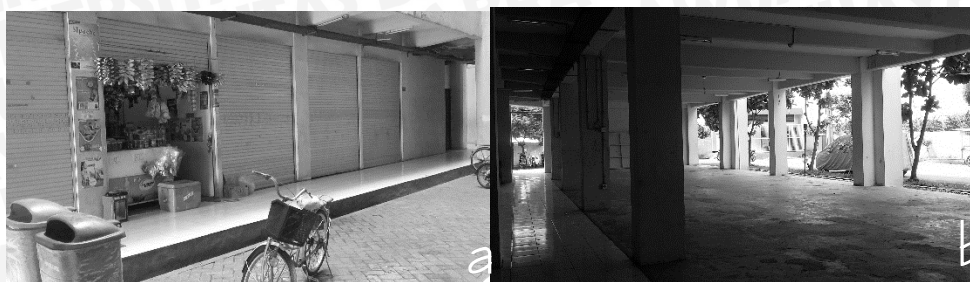
Gambar 2.9: Kondisi unit-unit kios (a) dan open plan di lantai dasar (b) pada Rusun Pinus Elok
