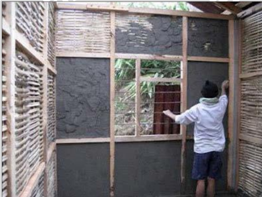
Gambar 2.15 Penerapan bambu plester Sumber : www.bambus.com
