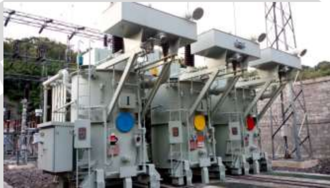
Gambar 4.1 Transformator Utama Unit I di PLTA Sutami Sumber : PLTA Sutami
