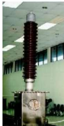
Gambar 2.5 Contoh Bushing Transformator Sumber : PT PLN (Persero) P3B, 2003;20
