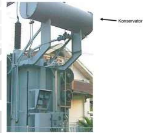
Gambar 2. 6 Tangki Konservator Sumber: PT PLN (Persero) P3B, 2003;23
