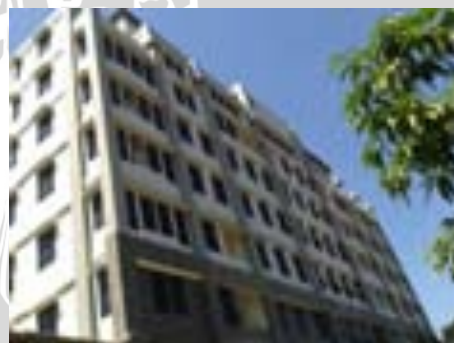
Gambar 4.5 Fasad sisi Barat
