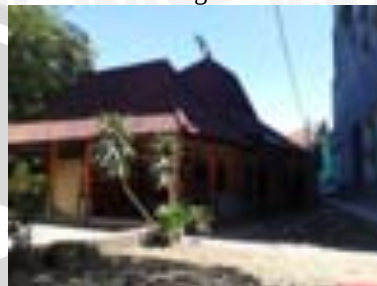
Gambar 4.12 Mushola di sisi Selatan
