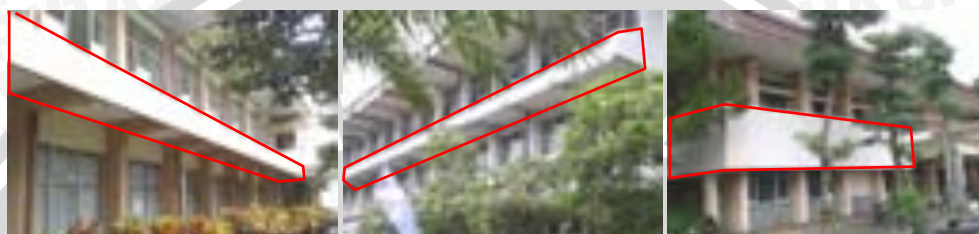
Gambar 4.15 Penerapan tritisan
