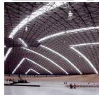
Gambar 4.38 Struktur kerangka space frame
