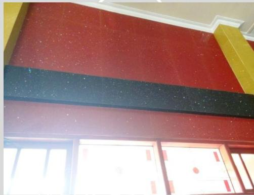
Gambar 4.16. Garis hitam pada material keramik dinding kanan dan kiri bagian atas
