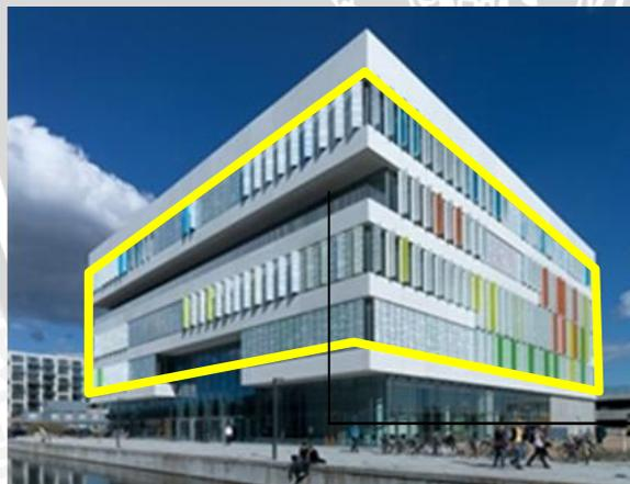
Peletakan fasad pada Orestad Upper Secondary School terlihat pada sistem fasad dinamis yang tidak dipasang pada semua sisi melainkan beberapa sisi saja dengan sistem overhang untuk menaungi yang tidak menggunakan fasa dinamis. Sistem ini juga termasuk keamanan bagi siswa karena sistem gerak fasad yang otomatis maka perlu pengamanan.
