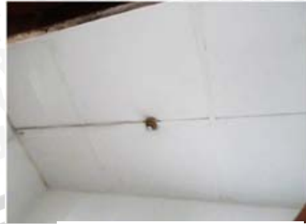
Kondisi eksisting plafon pada ruang KM
