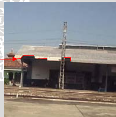
Area lokasi adanya kerusakan atap peron
