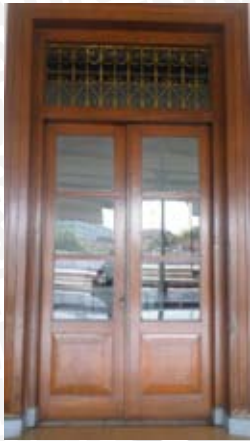
Gambar 4.127. Kondisi eksisting pintu interior P3 pada bangunan stasiun Solo Jebres
