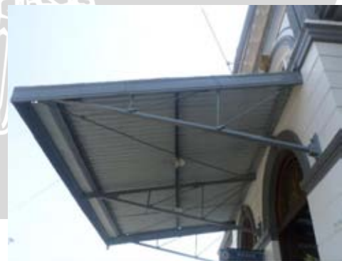
Gambar 4. 187 Eksisting atap miring pada bangunan stasiun Solo Jebres
