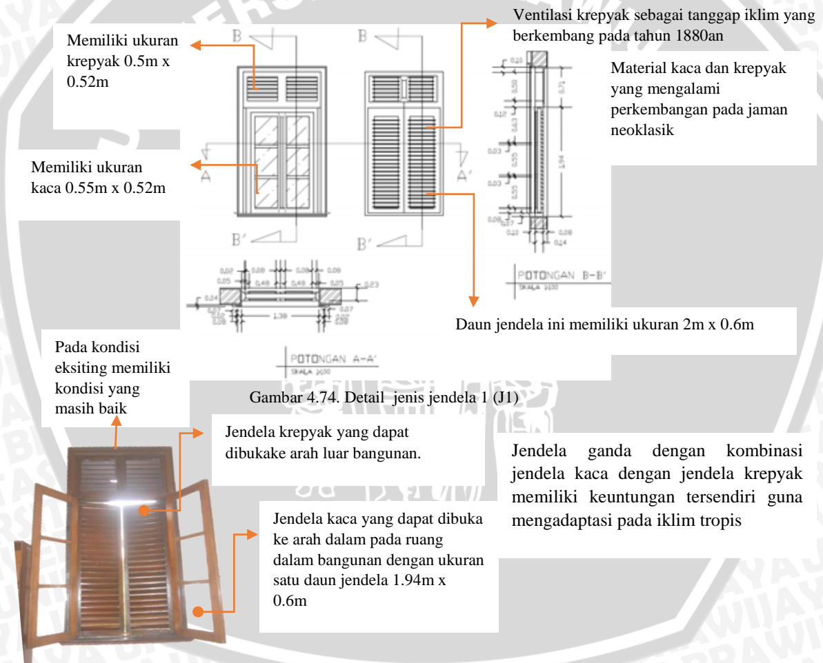
Gambar 4.75. Kondisi eksisting jenis jendela 1 (J1)
