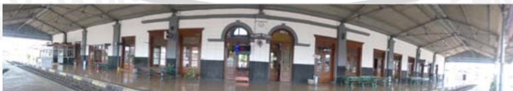
Gambar 4.91. Kolom struktur pada ruang tunggu peron
