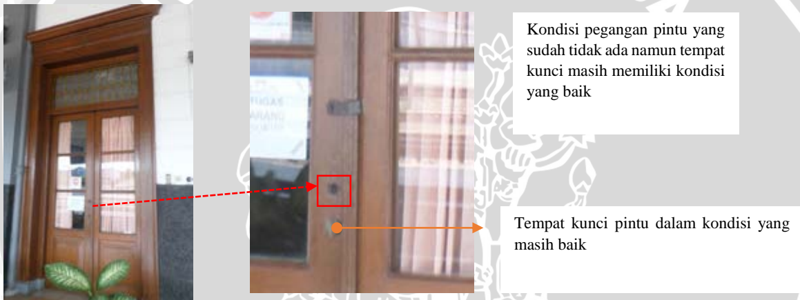
Gambar 4.70. Eksisting kerusakan A pada jenis pintu ruang tiket
