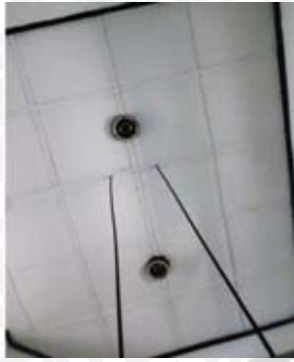
Kondisi eksisting plafon pada ruang PBD
