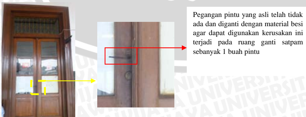
Gambar 4.71 Eksisting kerusakan A pada jenis pintu ruang ganti satpam
