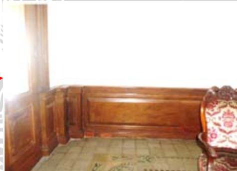
Gambar 4.124. Dinding interior ruang kesunanan pada bangunan Stasiun Solo Jebres
