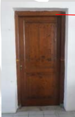
Gambar 4.129 Kondisi eksisting jenis pintu P5
