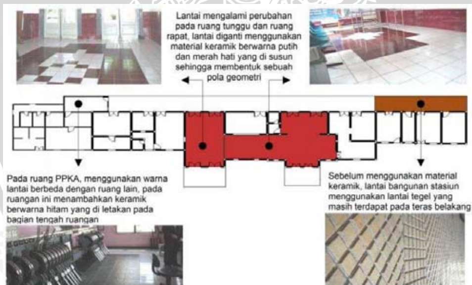
Gambar 2.8 Penggunaan material lantai pada bangunan stasiun Probolinggo.
