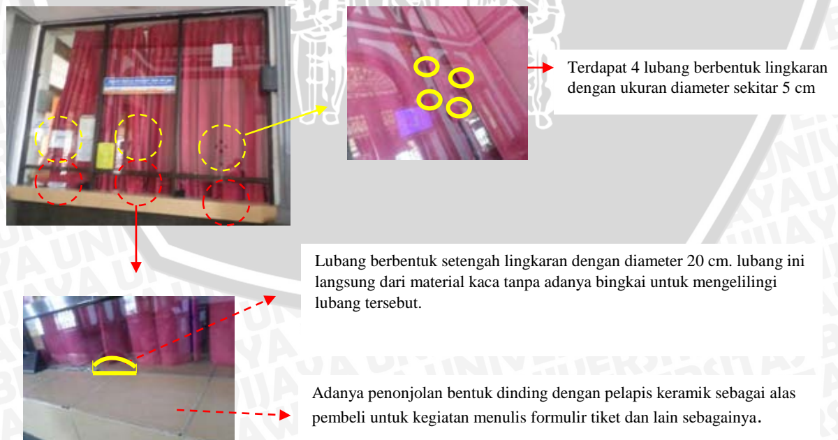
Gambar 4. 146 Jenis jendela 2 pada bangunan stasiun Solo Jebres
