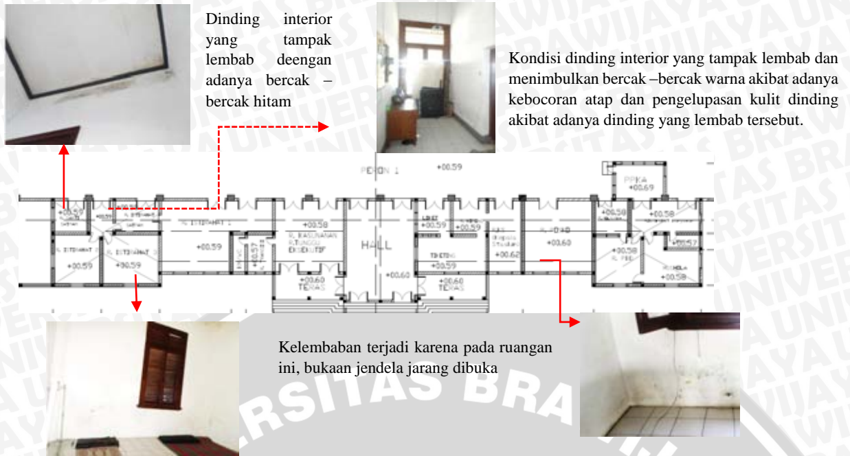
Gambar 4.125. Eksisting kerusakan dinding interior pada bangunan stasiun Solo Jebres
