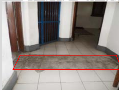
Gambar 4.164. Kerusakan lantai pada ruang istirahat
