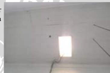
Gambar 4. 171 Kondisi eksisting jenis plafon 3 pada bangunan Stasiun Solo Jebres
