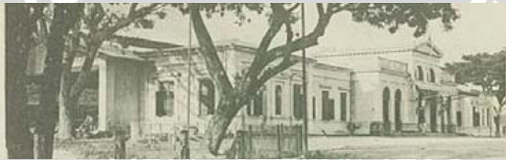
Gambar 4.41. Bangunan stasiun Solo Jebres pada tahun 1895-1905 Sumber : https://agustan.files.wordpress.com/2008/11/klv001009003.jpg
