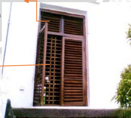
Gambar 4.78. Kondisi eksisting dan detail tralis pada Jenis jendela 1 (J1.b)
