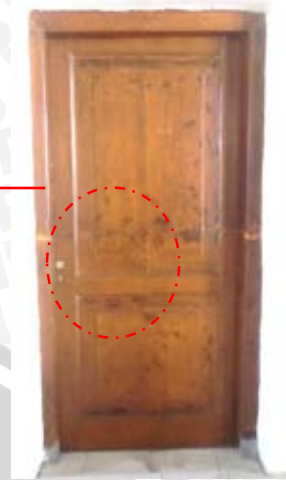
Gambar 4.142 Pegangan pintu pada jenis pintu P5
