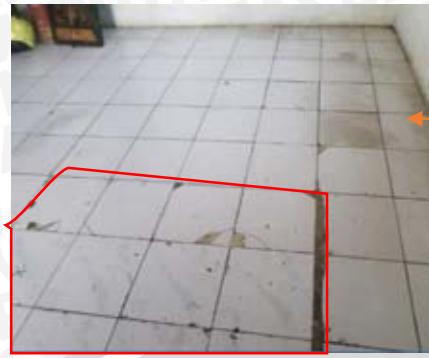
Gambar 4.163. Kerusakan lantai pada ruang ganti satpam
