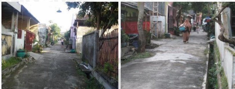
Gambar 4. 13 Visual Segmen VL-27 yang terlihat kurang terawat
