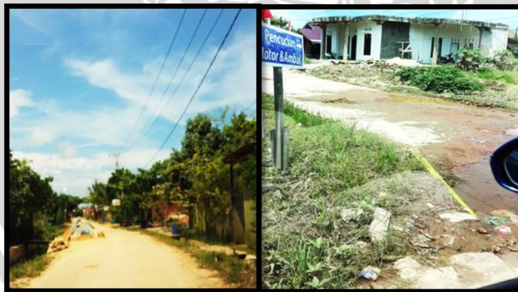
Gambar 4.14 Kondisi Jalan di Desa Singa Gembara Sumber : Survei Primer, 2014
